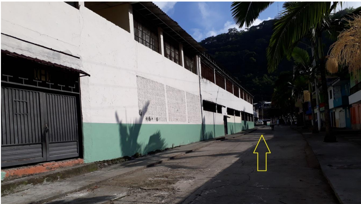
Fig 12. Calle principal Colegio, zonas duras en mal estado, tanto aceras como ruta de automóviles
