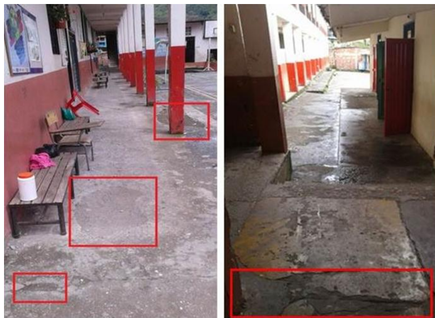
Fig 2. Pasillo 1 primer piso. (A) Suelo desgastado y columna agrietada. (B) Suelo desgastado y agrietado.
