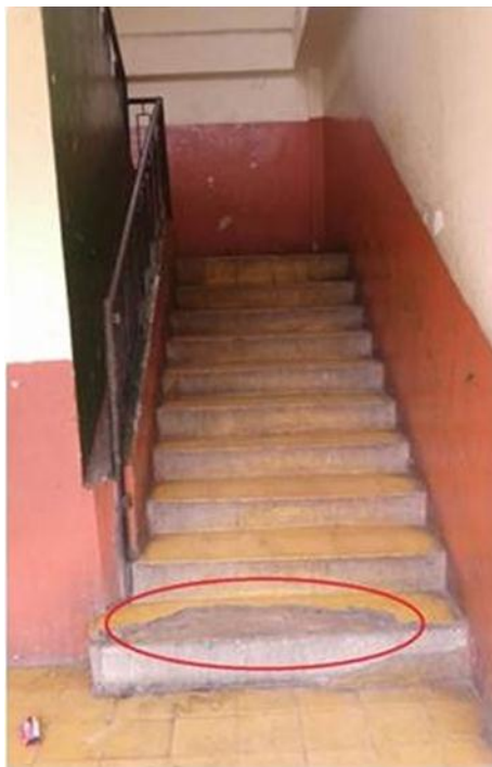
Fig 4. Escalas 2. (A) Escalas con alto nivel de desgaste en baldosa. (B) Escalas agrietadas.
