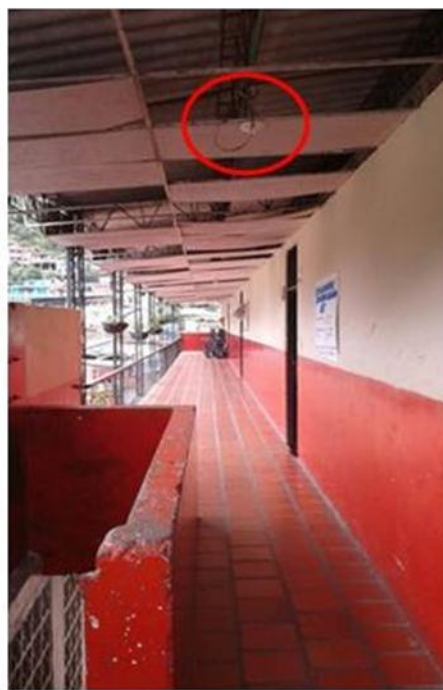
Fig 8. Pasillo 1 segundo piso (A) Cielo raso deteriorado con láminas duras inestables (B) Cielo raso con cableado eléctrico expuesto.
