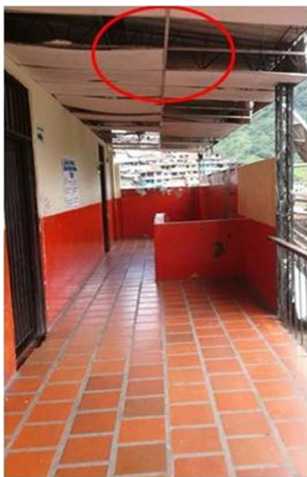
Fig 8. Pasillo 1 segundo piso (A) Cielo raso deteriorado con láminas duras inestables (B) Cielo raso con cableado eléctrico expuesto.
