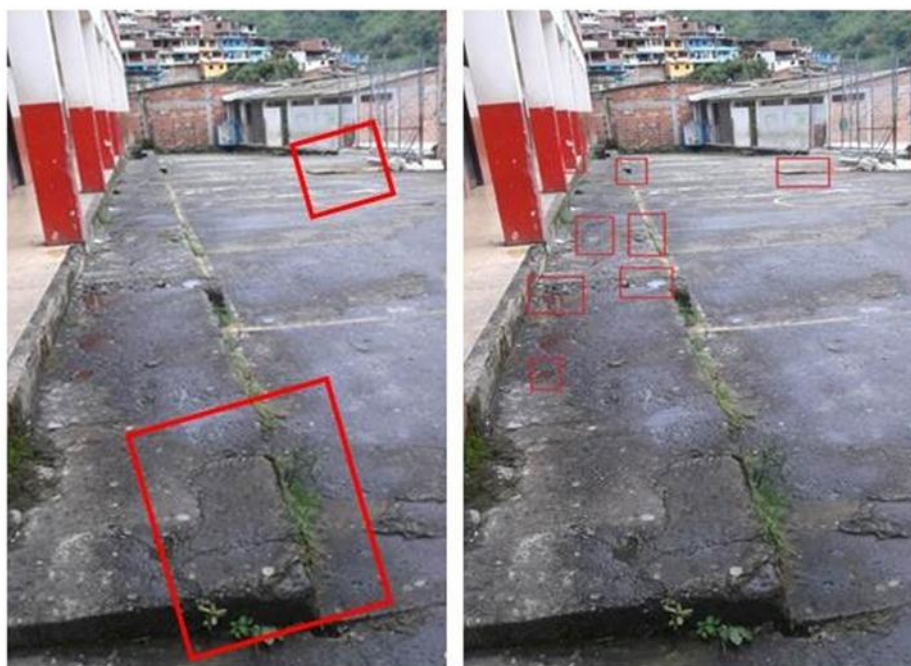
Fig 6. Patio 2. (A) Zonas duras agrietadas y con rotos (B) Zonas del patio con múltiples fracturas.
