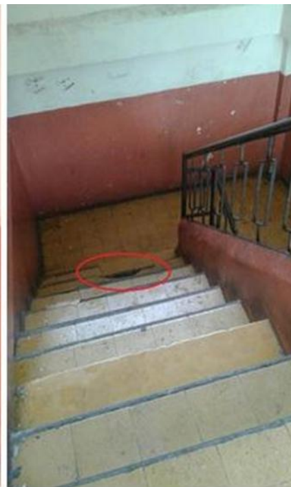
Fig 4. Escalas 2. (A) Escalas con alto nivel de desgaste en baldosa. (B) Escalas agrietadas.
