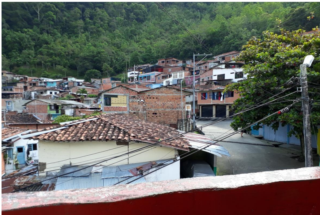
Fig 19. Sitios aledaños a la Institución, posible riesgo antrópico y natural, por intercambio comercial ilícito y derrumbes.
